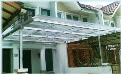
Carport : Rangka baja ringan + penutup atap polycarbonate.
