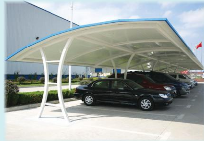
Struktur atap : Baja conventional + penutup atap polycarbonate.
