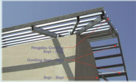
PEMASANGAN PERKUATAN PADA AREA TERITISAN SOPI - SOPI
